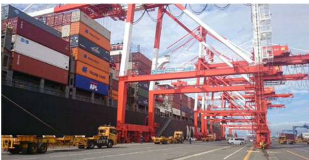
写真 4-1-2 神戸港コンテナターミナルの利用状況（筆者撮影）
