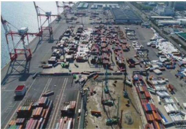
写真 4-1-5 コンテナターミナルの高潮被災事例 (神戸港) (PARI VOL.43 より引用) 5)
