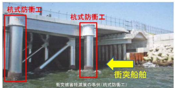
写真 4-1-3 走錨対策の事例（国土交通省港湾局 HP より引用） 3)
