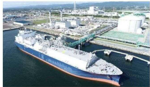
図 4-2-8 相馬 LNG 基地 5) (相馬市 HP より)
