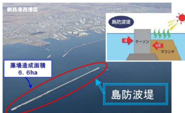
図 6-2-10 釧路港における防波堤背後の盛土上の藻場造成
