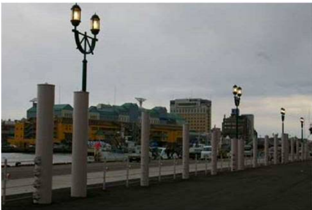
図 4-4-6 津波漂流物対策施設（釧路港） 3)
