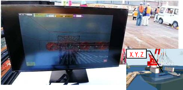
図 4-7-10 起重機船での函体設置時の BIM/CIM データ活用例 1)
